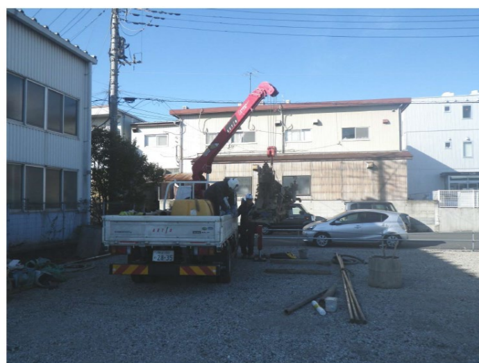
3tトラックによる積み下ろし状況
